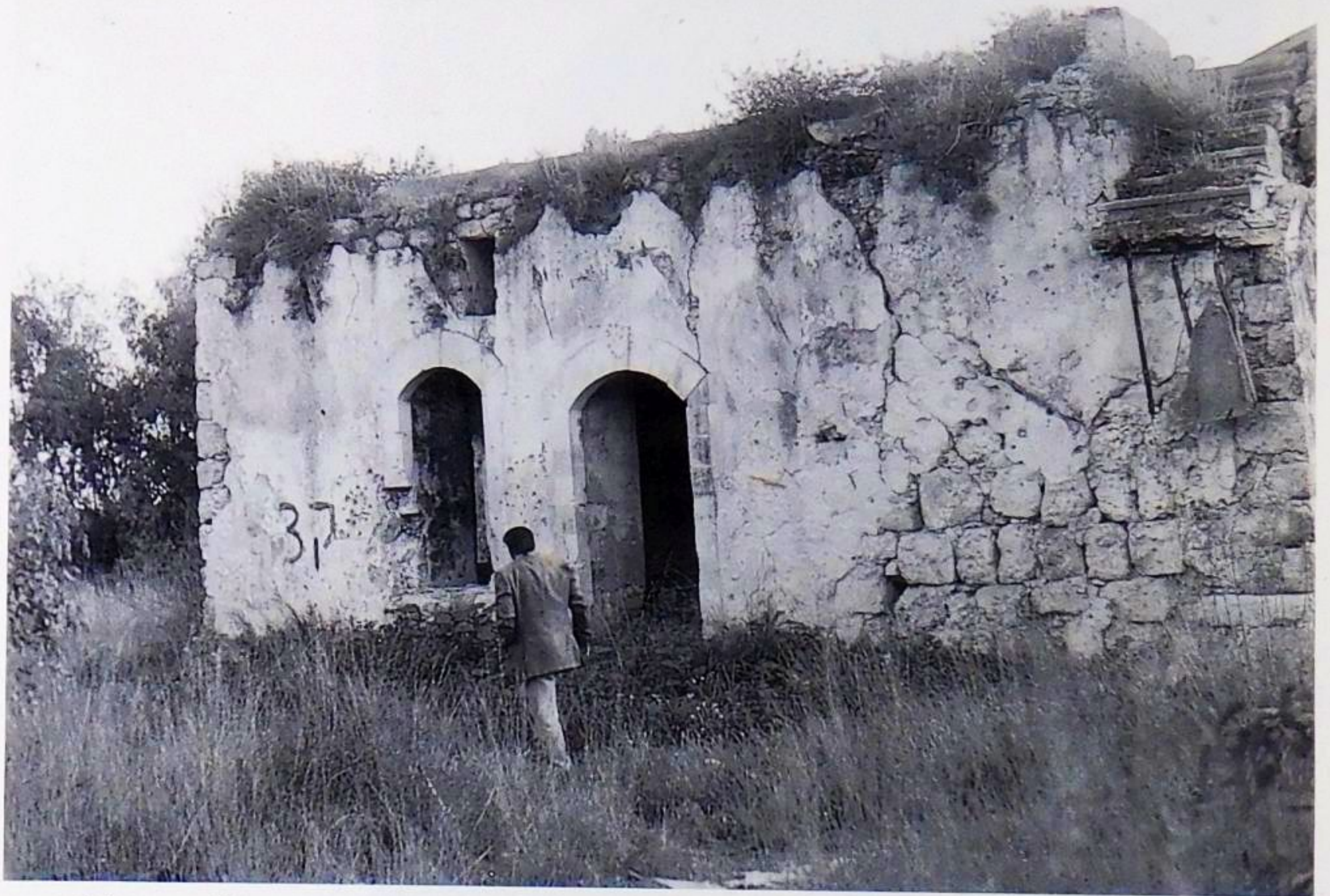
(٥) مسجد القرية القديم ، أما المسجد الجديد والذي كان ملتصق به فقد تم هدمه عام ١٩٤٨ ، وقضبان الحديد التي تظهر فى الصورة هى جزء من المسجد الجديد
